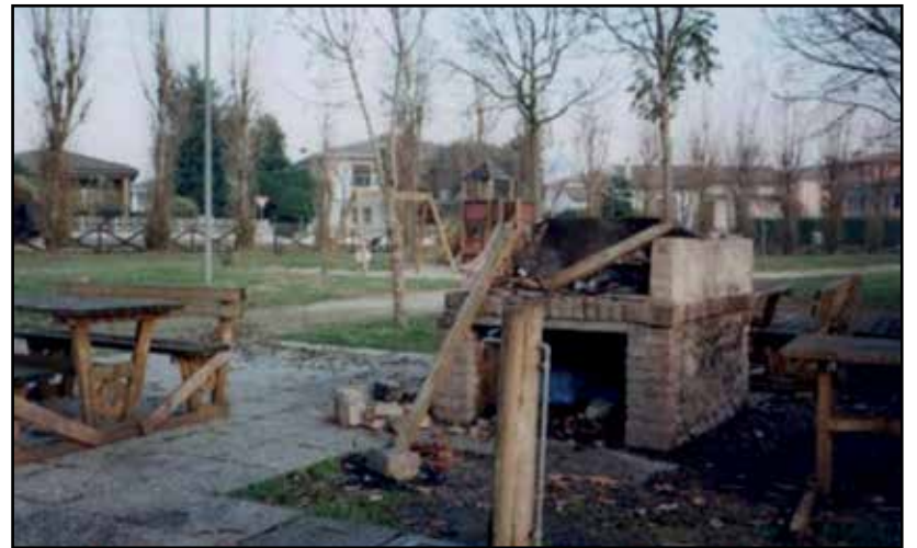
Dopo il passaggio dei vandali.
